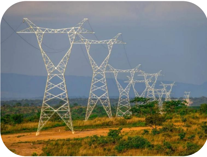
Figure 2: Linha de transmissão de alta tensão típica em Angola.
