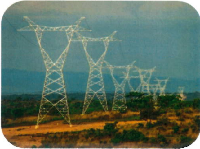
Figure 22: Linha de transmissão de alta tensão típica em Angola.
